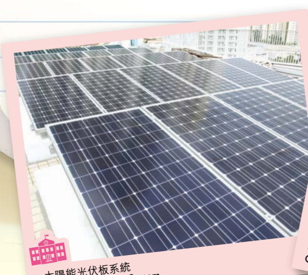
太陽能光伏系統 Photovoltaic Panel System
